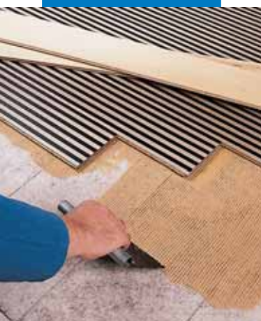
Montaż kolorowych listewek na starym podłożu przy użyciu Lignobond
