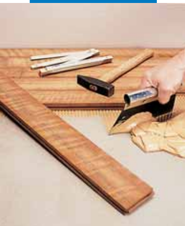
Montaż parkietu przy pomocy kleju Lignobond
