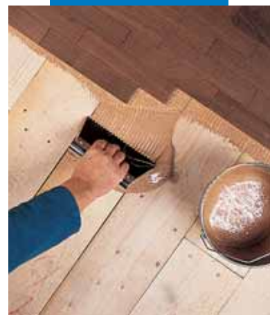
Montaż parkietu na starym podłożu drewnianym przy użyciu Lignobond
