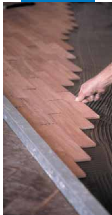
Przykład montażu parkietu na starym podłożu ceramicznym przy użyciu Lignobond
